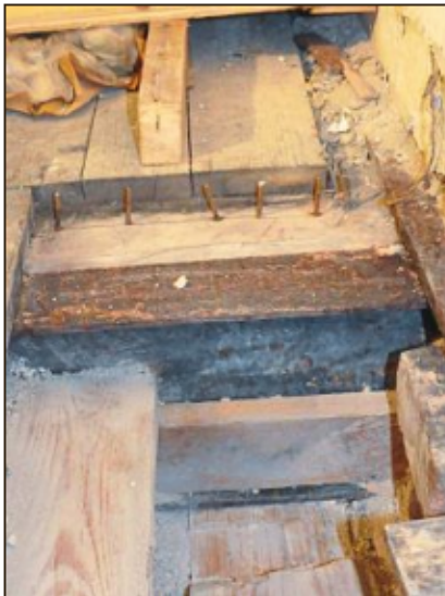
Die Öffnung im Bodenaufbau des ersten Obergeschosses zeigt, wie bereits bei früheren Umbauten Stahlträger eingefügt wurden, um die historischen Holzbalken zu stabilisieren.
